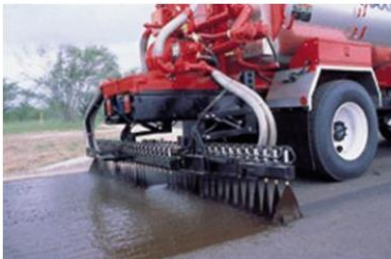
Figura 2 - Imprimação de base com uso de CM-30
