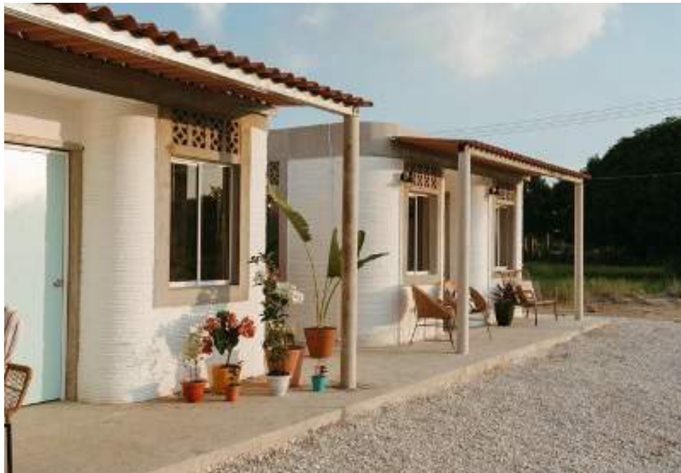
Figura 6. Uma parte do conjunto de casas fabricadas pela impressora 3D na comunidade de Tabasco, México.
