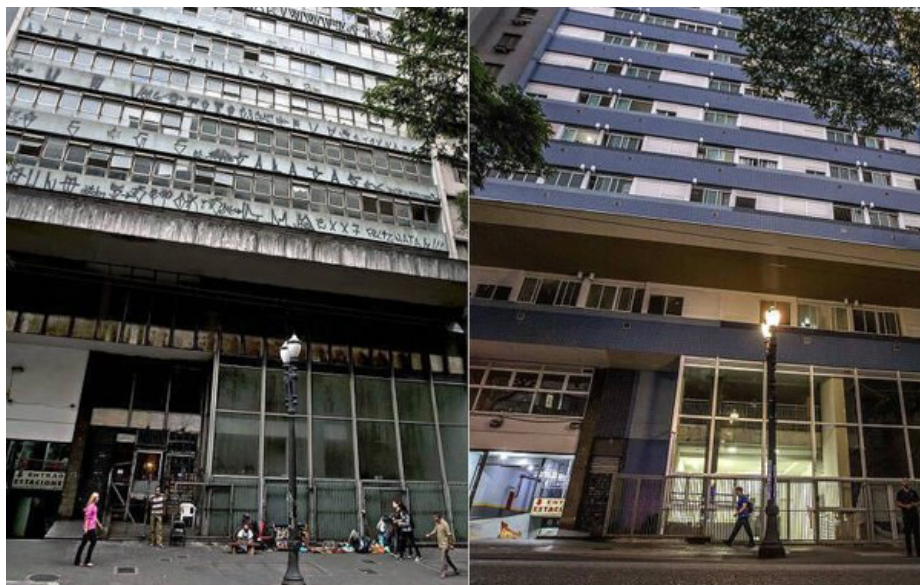
Figura 7. Antes em 2011 e depois do projeto de retrofit do Edifício Dandara, em 2018.
