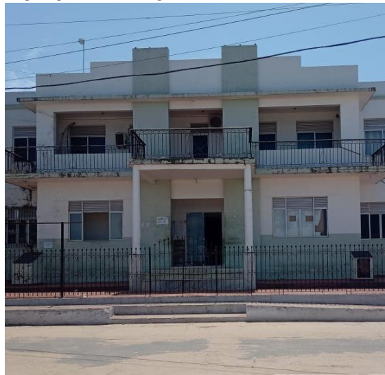
IMAGEM 02 – PRÉDIO DA PREFEITURA MUNICIPAL DE PORTEL – PARÁ.
