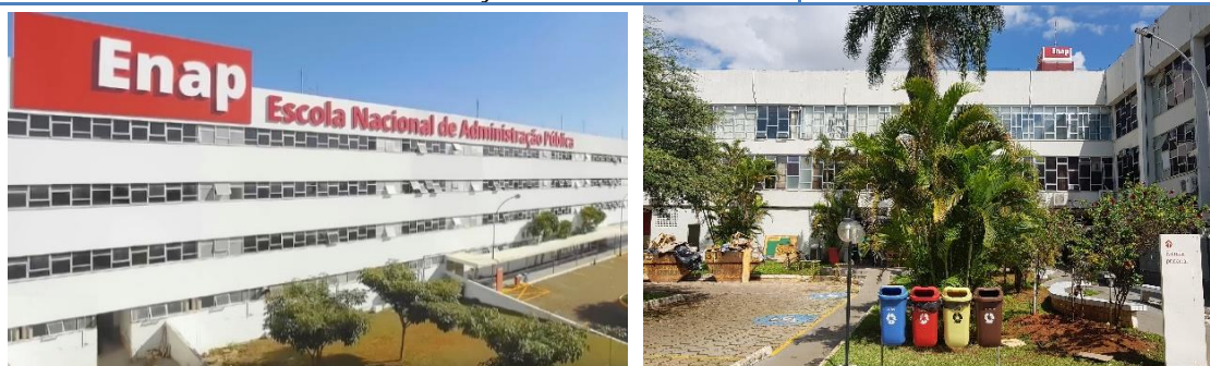
Imagem 2 – Fachada da Enap.
