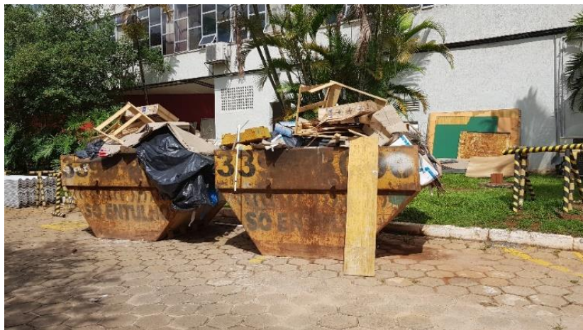
Imagem 23– Caçambas de 5m 3 para acondicionamento de resíduos da construção civil, podas e diversos.
