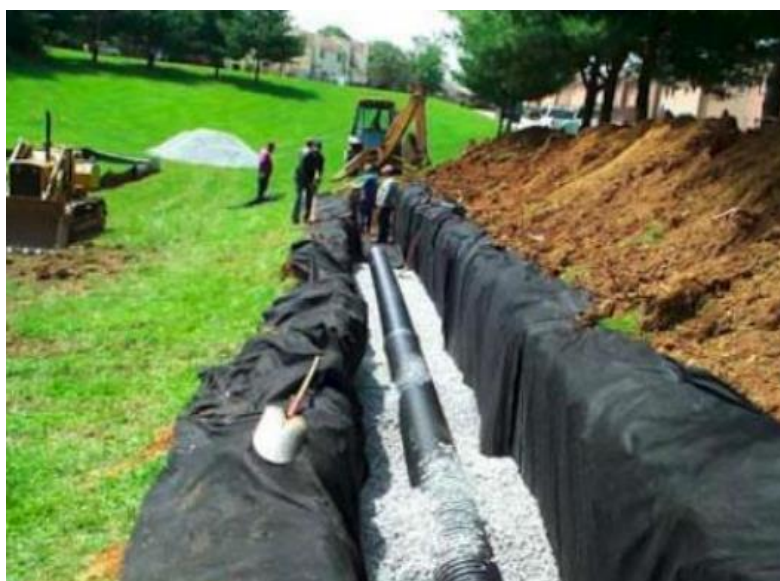
Figura 16 - Execução de uma trincheira Perfis. Fonte: CIRIA, (2007)
