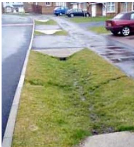
Figura 18 – Vala de Infiltração. Fonte: CIRIA, (2007)
