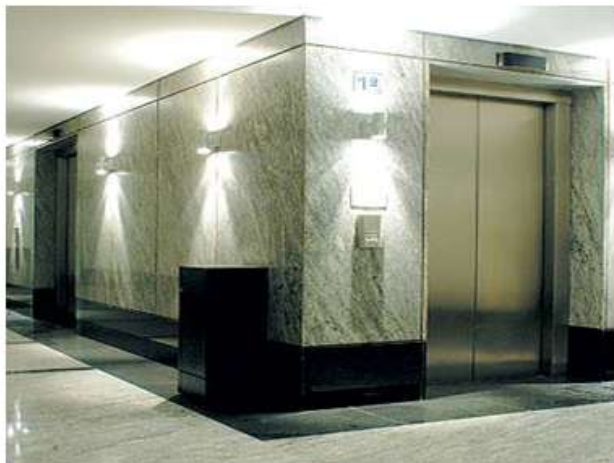
Serviço de Manutenção em Elevadores
