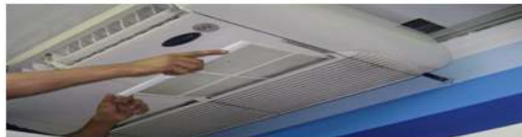
Serviço de Manutenção em Ar Condicionado
