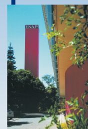
Reforma da fachada da ENAP
