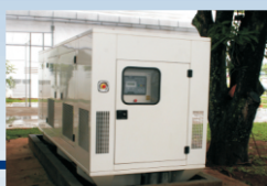
Instalação do Gerador de Energia para evitar desgaste dos equipamentos
