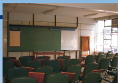
Reforma nas Salas de Aula
