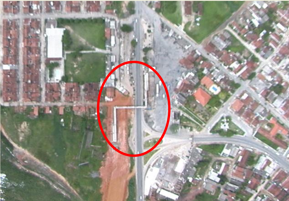
Passarela , ainda sem acessos
