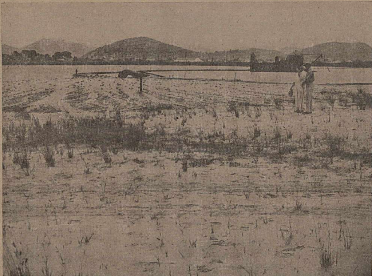
Uma das 3 dragas, realizando aterros hidráulicos
