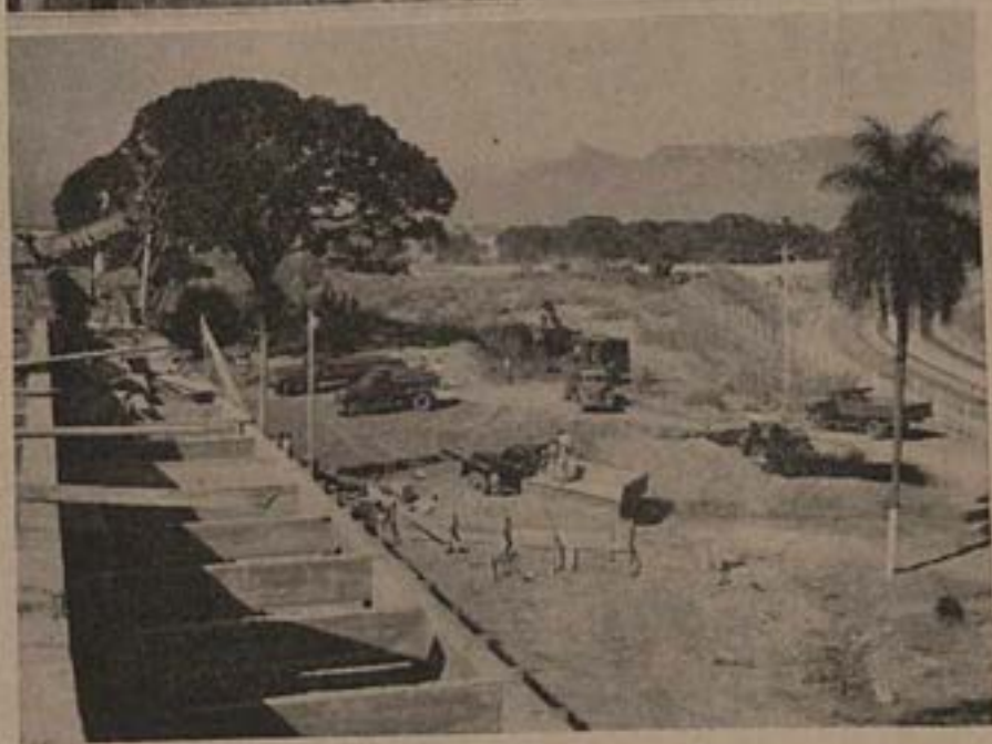
3. Aspecto da construção
