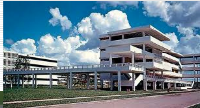
Projeto ambicioso em concreto estruturado
