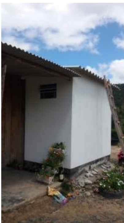
Figura 21 - Vista externa 2 de construção de MSD interligada à residência.
