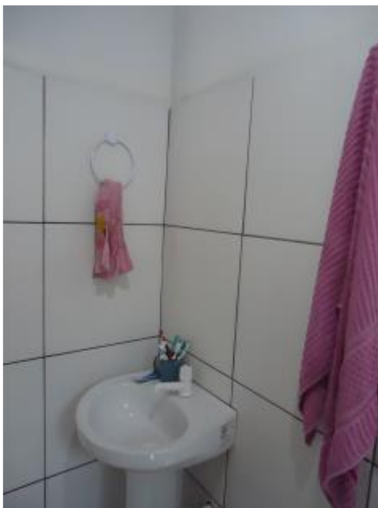
Figura 24 - Vista interna de exemplo 3 de MSD interligada à residência.
