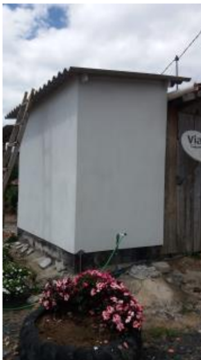
Figura 20 - Vista externa 1 de construção de MSD interligada à residência.
