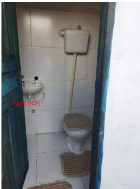
Figura 22 - Vista interna de exemplo 1 de MSD interligada à residência.
