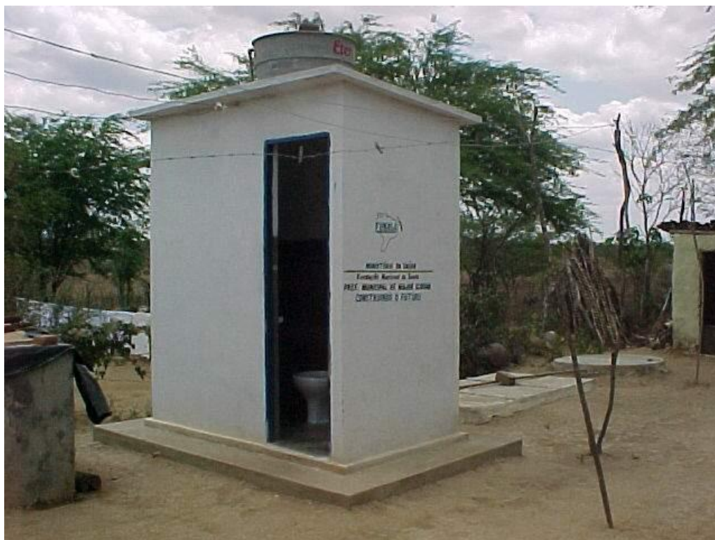
Figura 27 - Exemplo 2 de construção de MSD com identificação institucional.
