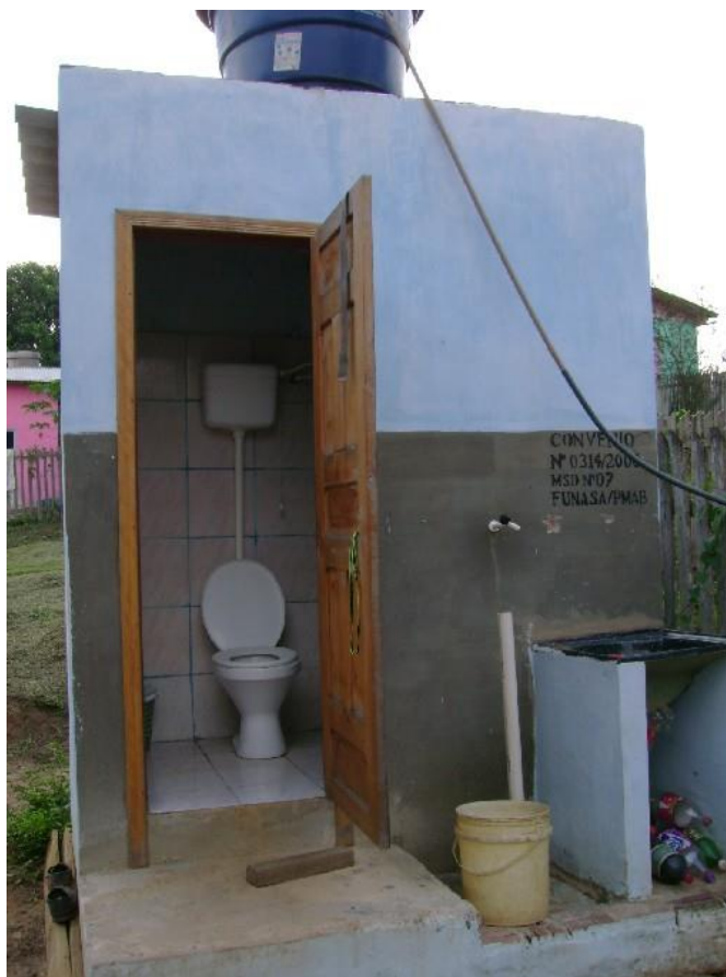
Figura 28 - Exemplo 3 de construção de MSD com identificação institucional.
