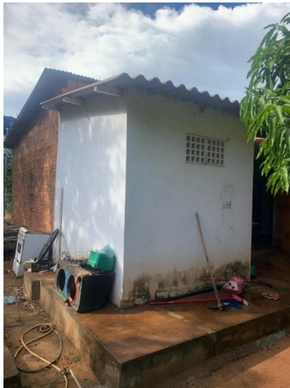
Figura 19 - Vista 2 de banheiro 2 (adaptado só à PCD) interligado à residência.
