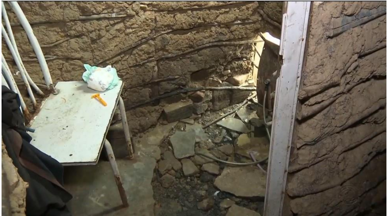
Figura 8 - Exemplo de residência sem instalação sanitária adequada.
