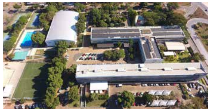
Figura 1 - Instalações prediais e desportivas - Enap
