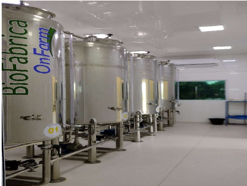
Figura 10. Tanques de fermentação em aço inoxidável com capacidade de 1000L cada em área refrigerada.
