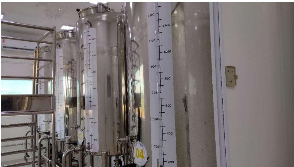
Figura 12. Reservatórios de 1000L em inox para armazenamento/recirculação.
