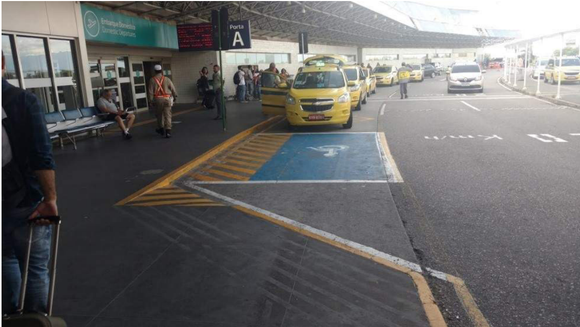
Fig. 30: Na Imagem acima é possível visualizar a vaga acessível de embarque e desembarque paralela a calçada do Aeroporto Galeão no Rio de Janeiro com área destinada a manobra na lateral da vaga. Nota-se que a rampa de rebaixo do meio fio foi executada na diagonal do piso, o que provavelmente dificultará a subida pelo usuário de cadeira de rodas. Em contrapartida, a vaga está posicional no local mais próximo do acesso principal e está bem sinalizada com pintura de piso.
