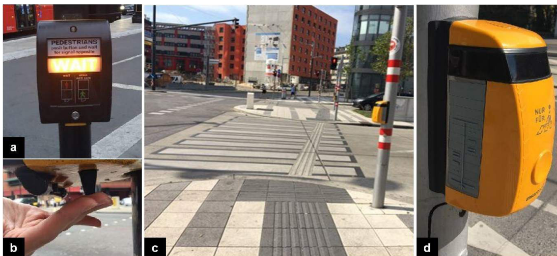
Fig. 25: Sinalização semafórica da travessia utilizada em Londres, Inglaterra, contendo letreiro luminoso com as palavras Wait em vermelho e Go em verde (Imagem a) e cone giratório na parte inferior (b) para utilização de pessoas com deficiência visual. Nas Imagens c e d vemos sinalização de travessia em Viena, Áustria, com pisos táteis direcionais e de alerta antes e durante a travessia (c), na caixa de solicitação de travessia, em sua lateral, desenho em relevo simplificado da via, informa quantidade de faixas de rolamento de veículos.
