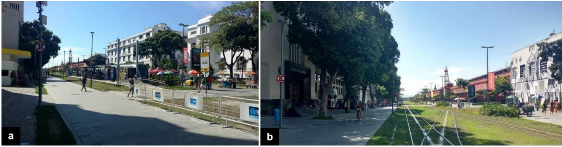
Fig. 3: a) e b) Diferentes ângulos da Avenida Rodrigues Alves na área portuária no Rio de Janeiro ilustram o conceito de rua completa com trânsito dos diferentes modais de forma equilibrada. Enfatiza-se o uso pelos pedestres do espaço público e atividades de permanência, assim como a presença de comércio informal além dos lindeiros.
