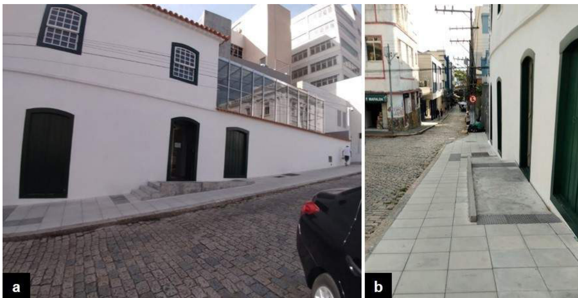
Fig. 43: Passeio em declive com acesso plano ao Museu Victor Meirelles em Florianópolis (SC). Fonte: a) Acervo pessoal de Carolina Pinto. b) Acervo pessoal de Marcia Loch.
