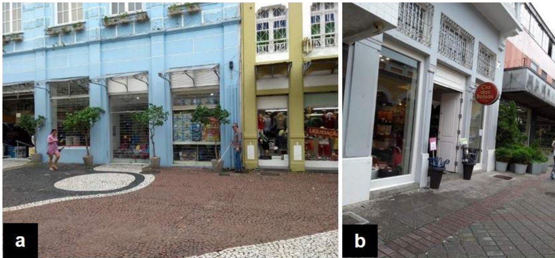
Fig. 33: (a) Floreiras ou (b) objetos (guarda-chuva) na área de acesso às edificações podem representar barreira para todos os pedestres e em especial para pessoas com deficiência visual na ausência de sinalização tátil de faixa livre na calçada.
