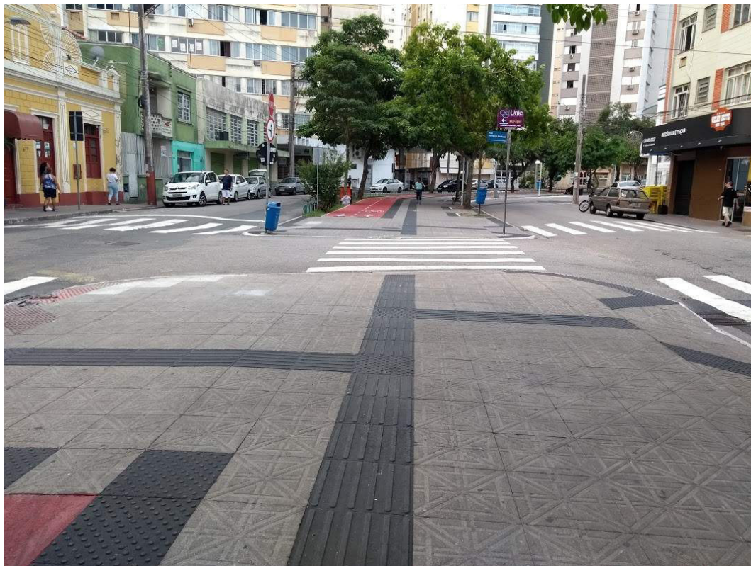
Fig. 20: Travessias através de rebaixamento da calçada (rampa a direita) e nivelamento de toda calçada com a via de trânsito veicular. Fonte: Acervo pessoal de Marta Dischinger.
