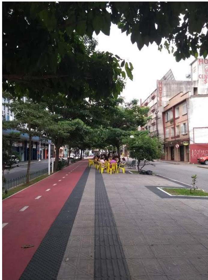
Fig. 5: Ciclofaixa na Avenida Hercílio Luz com piso tátil de alerta sinalizando o limite entre a ciclofaixa e a faixa livre, e piso tátil direcional sinalizando uma rota segura.
