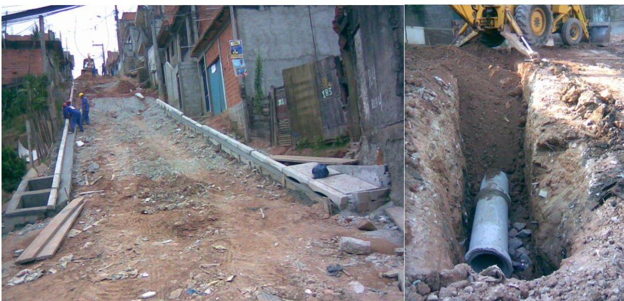
Fotos 7 e 8 - Rua Antonio Vidal: obras de pavimentação e drenagem. Foto: PMTS - SEHAB, 2014
