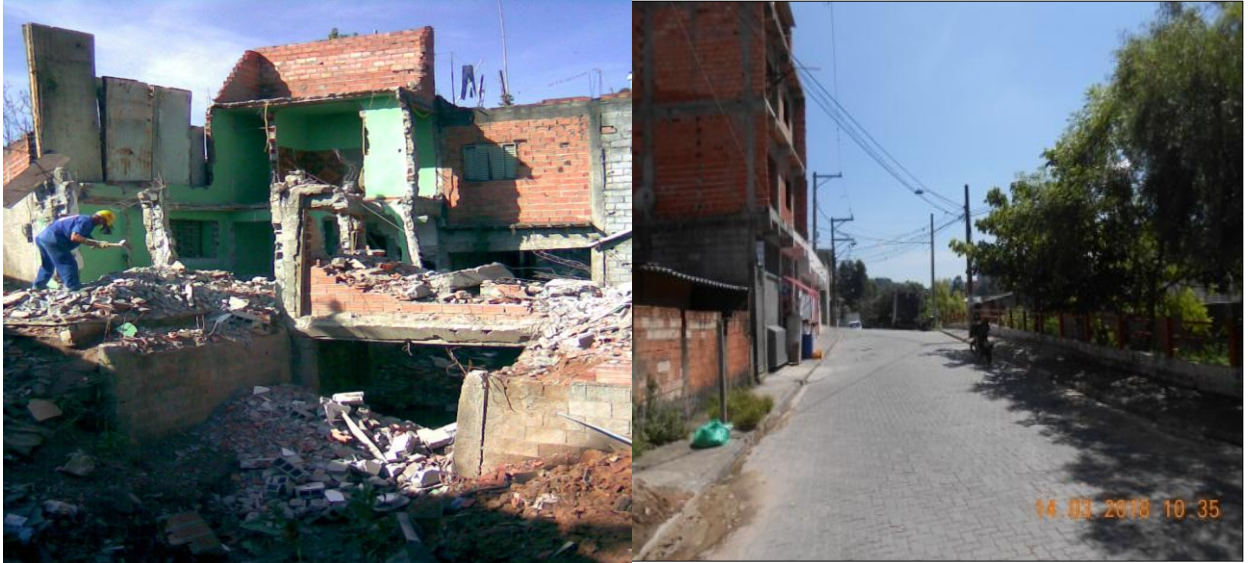
Fotos 09 e 10 - Rua Palmital: remoções e pavimentação. Foto: Arquivo PMTS – SEHAB, 2014/2018.
