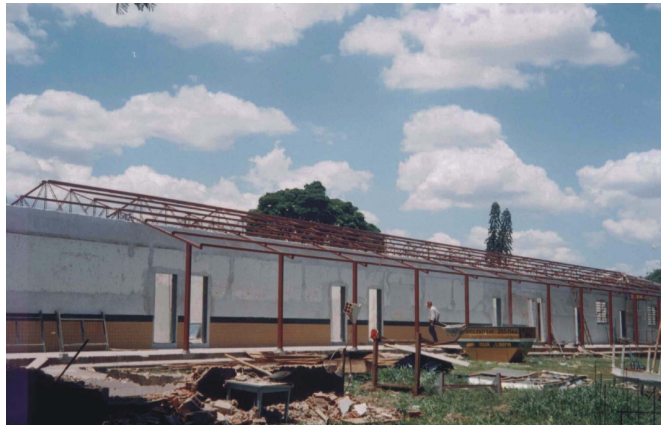
Aspecto geral do prédio, com nova cobertura, forro e sustentação.
