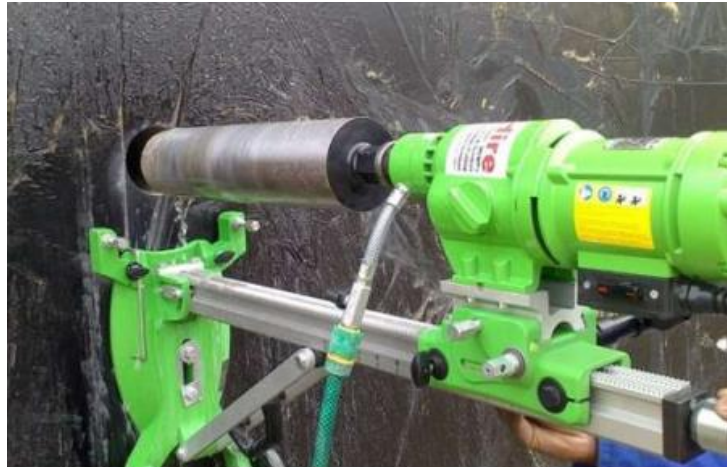
Figura 16 - Extração de corpo de prova de uma estrutura.
