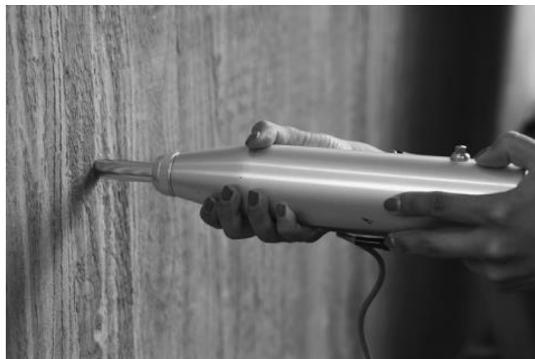
Figura 17 - Aplicação do esclerômetro em uma superfície de concreto.
