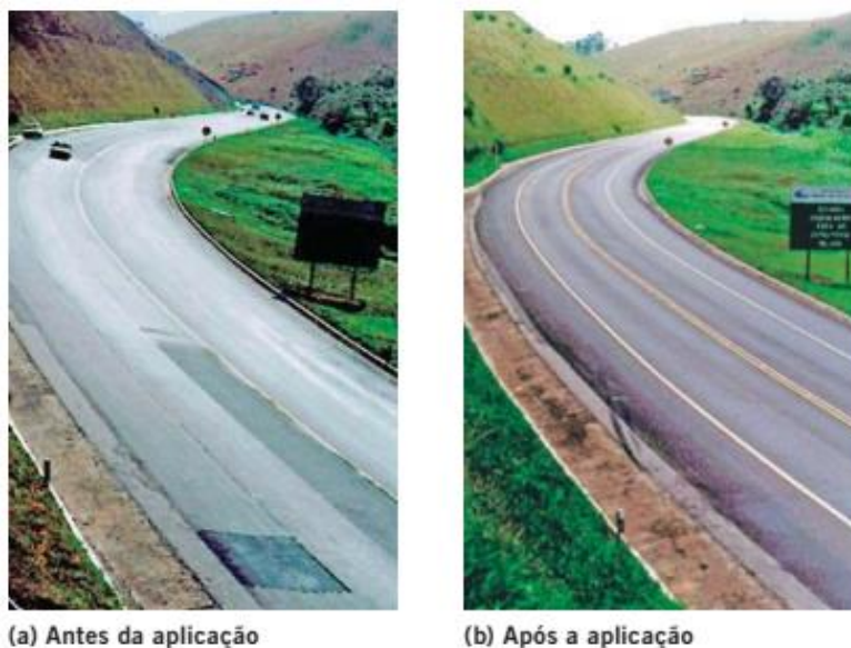
Figura 7 - Exemplo de aplicação de microrrevestimento asfáltico
