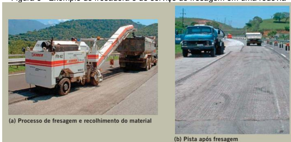
Figura 6 - Exemplo de fresadora e de serviço de fresagem em uma rodovia
