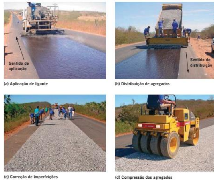
Figura 9 - Etapas construtivas do tratamento superficial simples
