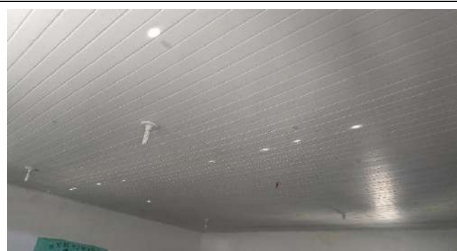
Figura 04 – FORRO SALA DE AULA
