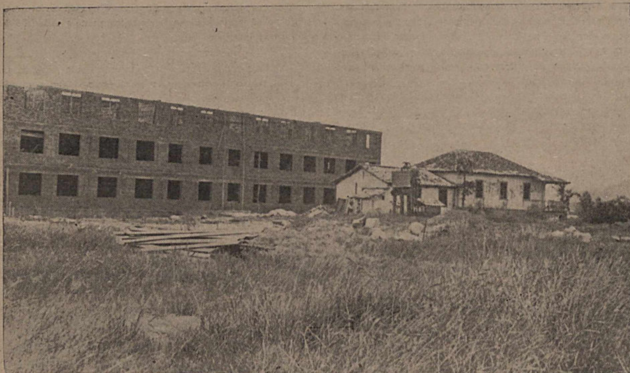
C.N.E.P.A. — Um dos edifícios destinados ao alojamento dos alunos, vendo-se ao lado a velha casa da Fazenda do Retiro, que será conservada
