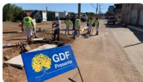
Limpeza de bocas de lobo na Estrutural
