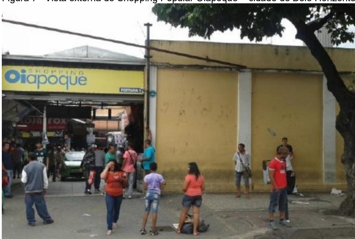
Figura 7 –Vista externa do Shopping Popular Oiapoque – cidade de Belo Horizonte
