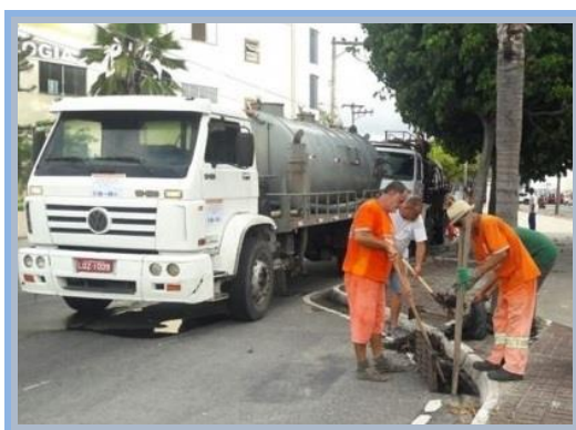
Figura 11: Equipamento e mão de obra para manutenção de redes de drenagem. Fonte: PMCF/COMSERCAF, 2018.
