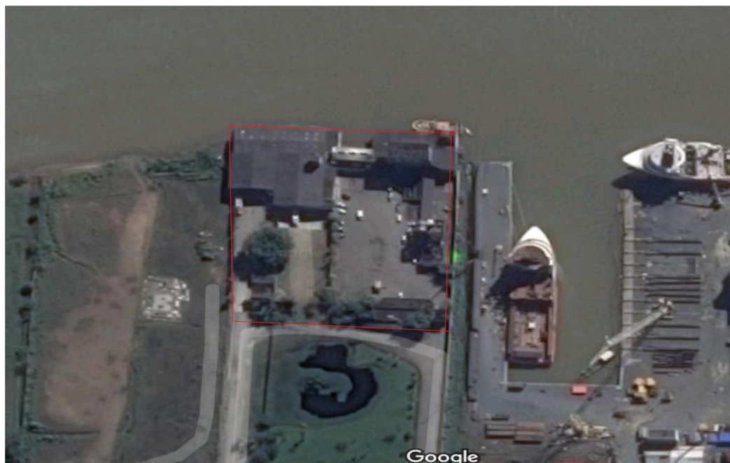
Figura 4. Imagem de satélite do empreendimento Star News Comércio e Importação de Alimentos LTDA.
