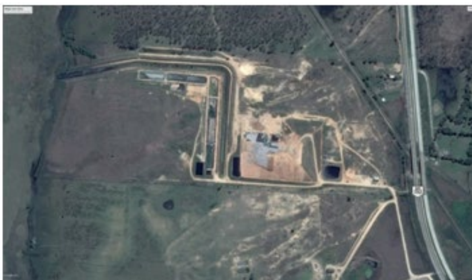
Figura 4-Vista Aérea do Aterro Sanitário da Quinta Fonte: Acervo da SMCSU
