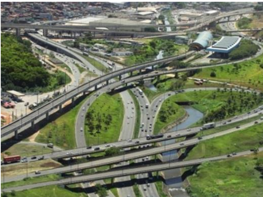
Figura 6 – Obra concluída – BR-324/BA – Via expressa
