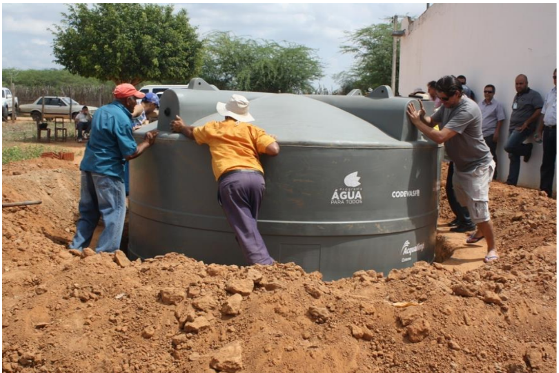
Instalação de cisterna – uso de mão-de-obra local. Figura 6 - Foto – MI/SDR
