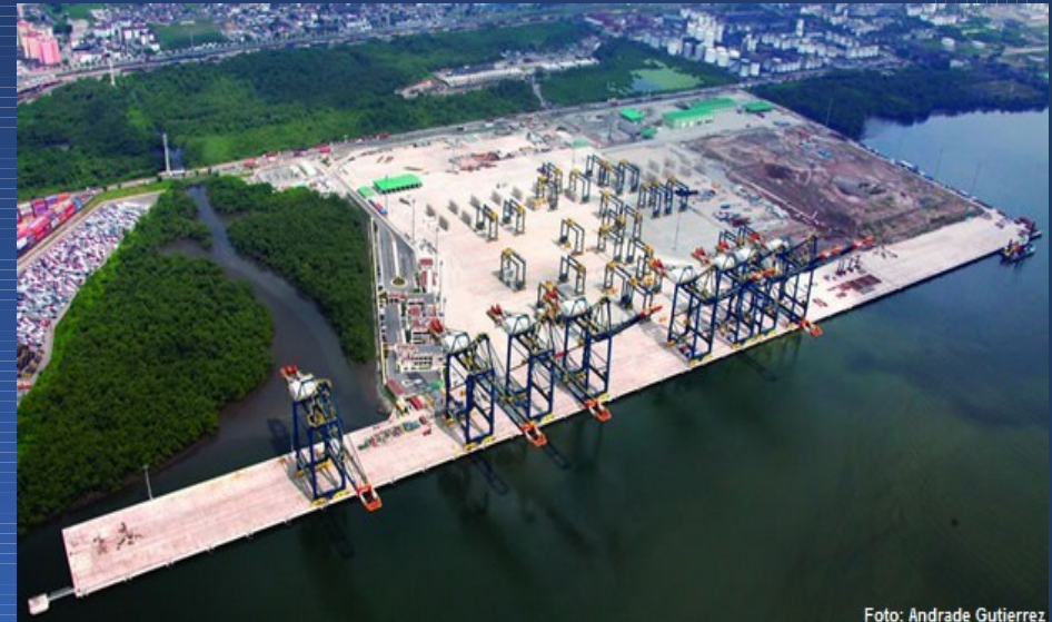
Terminal Portuário da BTP – Porto de Santos
