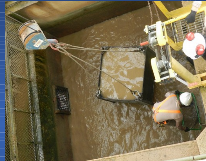
Operação do STP Jirau
