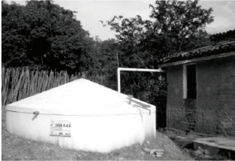
Figura 2 – Cisterna de placas de 16 mil litros construída no âmbito do Programa Cisternas
